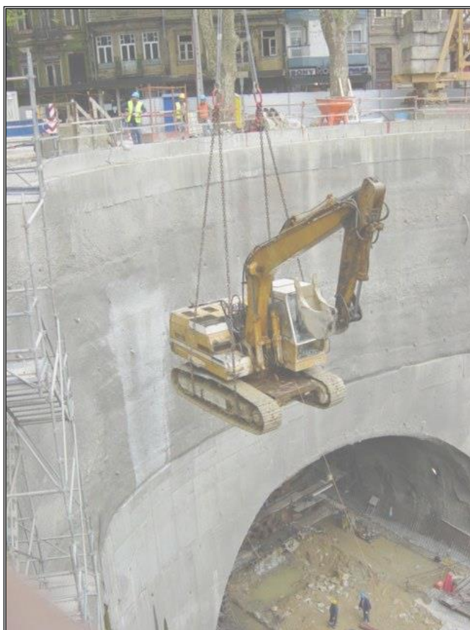
Obra da Estação do Marquês do Metro do Porto, Agosto de 2010
